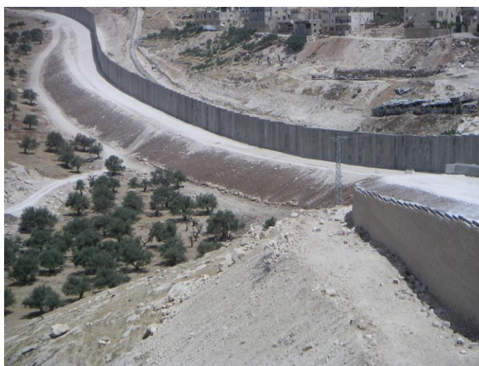
תמונה מס' 21. קירות בטון מודולריים המונחים זה לצד זה ומהווים חסימה מוחלטת לאורך קטעים בקו התפר. צילום: מוטי שפי.
